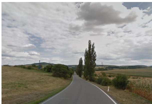
Pohled na plochy povodí KB - silnice od Mokrovrat směřující ke Starému Knínu
