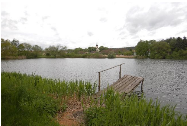
Profil KB na hrázi rybníka Antonín - pohled na obec Pičín v povodí KB
