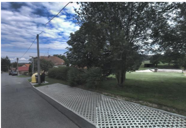
KB na okraji zástavby obce Dubno - profil KB se nachází pod hrází koupaliště na bezejmenném přítoku Kocáby
