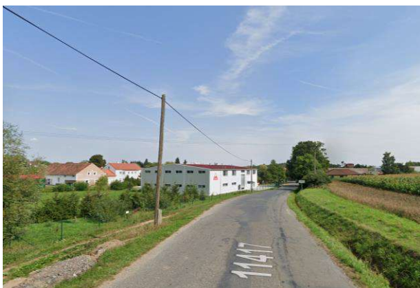
KB na bezejmenném vodním toku na západním okraji obce Suchodol. Těsně nad profilem KB je nově postavená průmyslová hala
