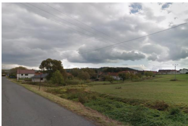
KB na Lhotském potoce na okraji zástavby obce Ouběnice (silnice od obce Ostrov)
