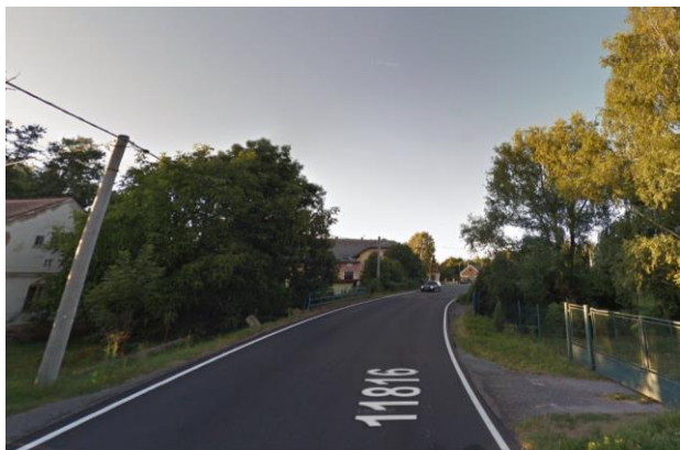
Propustek na Lhoteckém potoce v obci Ostrov - nachází se pod profilem KB
