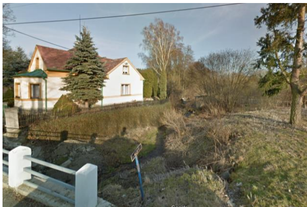
Pohled ze silničního propustku v obci Senešnice do toku Makyty (nad KB)
