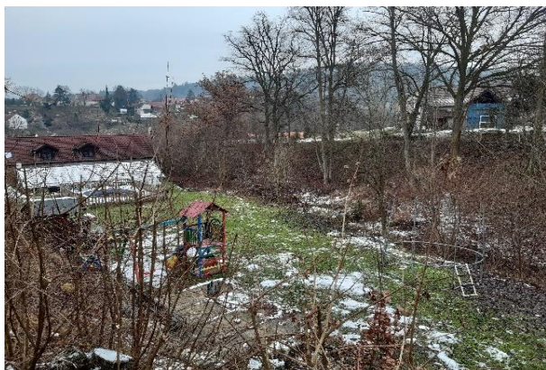
Pohled na KB na bezejmenném vodním toku - vtok do zástavby obce Velká Lečice
