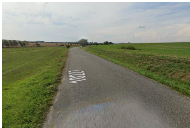
Pohled na přispívající plochy KB v dolní části povodí
