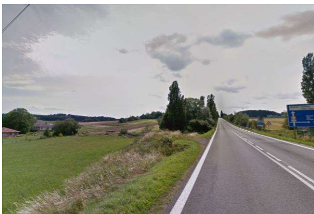
Pohled na KB na okraji zástavby obce Dubno
